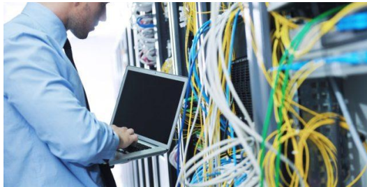
Imagen 30 Mantenimiento preventivo en equipos de red
